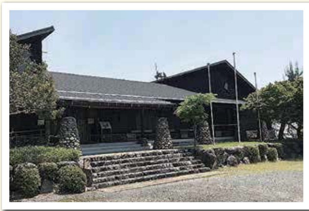
登攀競技管理棟 後に、比良山岳センター(昭和56年)
