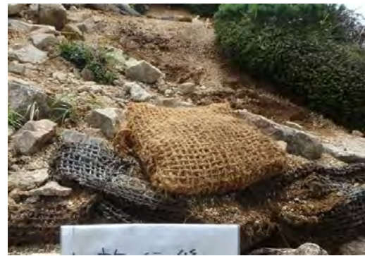
【3班 破れが見られた土嚢の補修】
