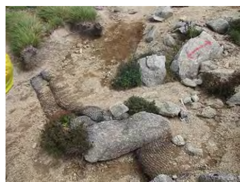
【砂防ダムの効果により土砂が堆積】
