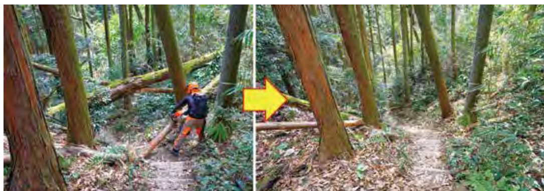
登山道の倒木除去作業中と作業後の状況
