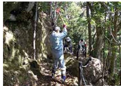
登山道に崩落した岩石の除去作業
