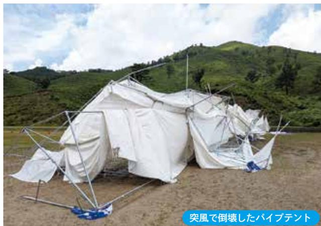
突風で倒壊したパイプテント
