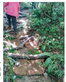
▶ブナの枯れ枝やヤシ土のうによる近自然工法で施工。束ねた柴が暗渠のため敷かれている
