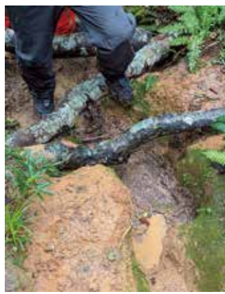
丸太を流木の仕組みで配置
